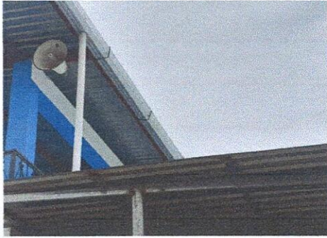
Foto1: CUBIERTA DE LÁMINA
