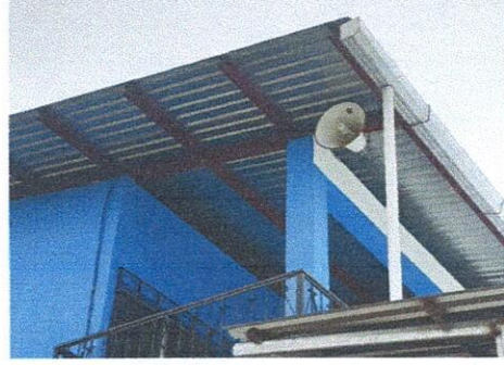
Foto 2: CANALES Y BAJADAS DE AGUA PLUVIAL
